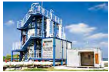
沖縄県海洋温度差発電実証施設と久米島サテライト
