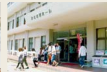
かささぎホール
